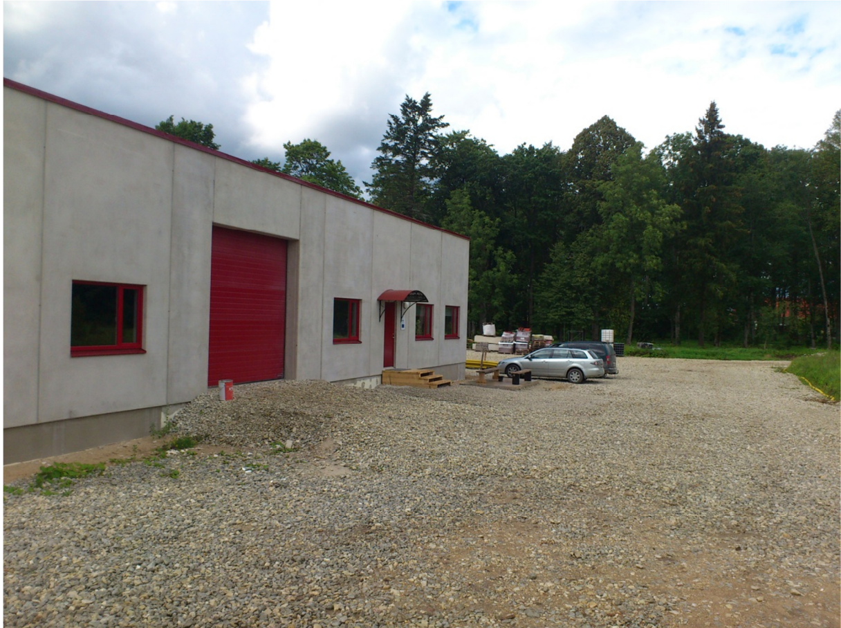
Joonis 5. Rutikvere 1 kalakasvanduse hoone.
