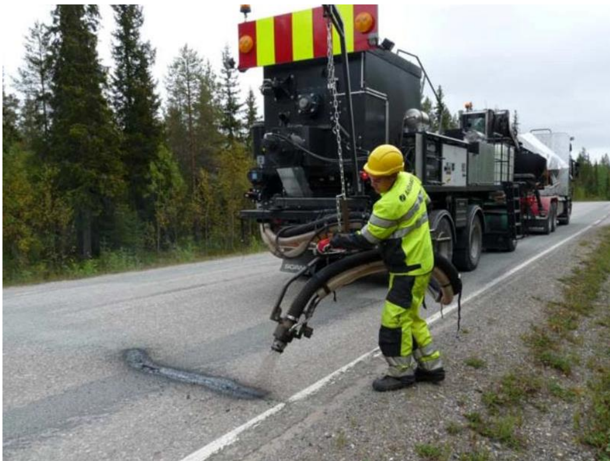
Foto 1. Pritskillustiku paigaldamine („Katete remondimeetodite valikupõhimõtted“)
